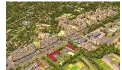
ЖК «Петровский», Свердловская область «Элит-групп»
