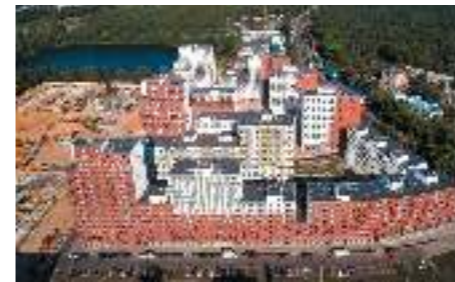
ЖК «Новокрасово», МО «Тройка РЭД»
